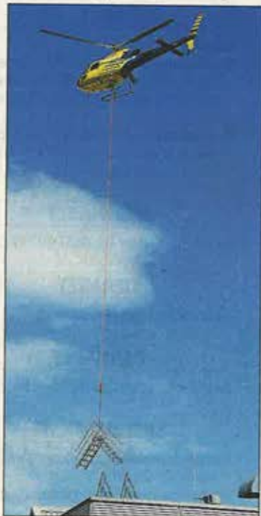
In der Luft: Der Hubschrauber fliegt die 200 Kilo schwere Treppe auf das Hallendach. FOTO: LOEFFEL
